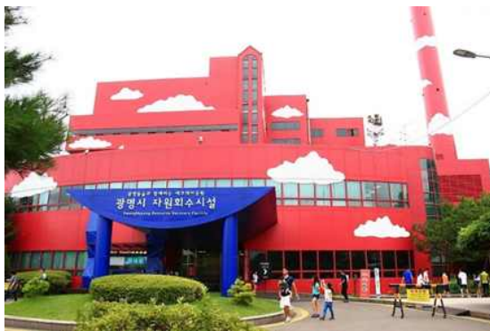
[그림 53] 광명시 자원회수시설 전경
