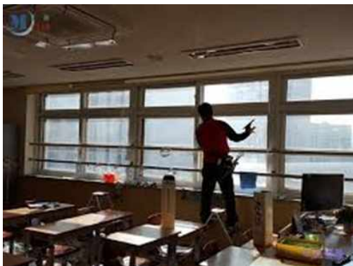
교실 창호 단열개선 필름 시공
