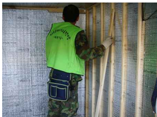
에너지효율화 시공 사례
