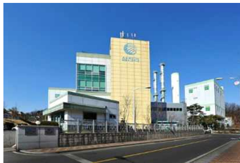
광명 삼천리 열병합사업단 전경
